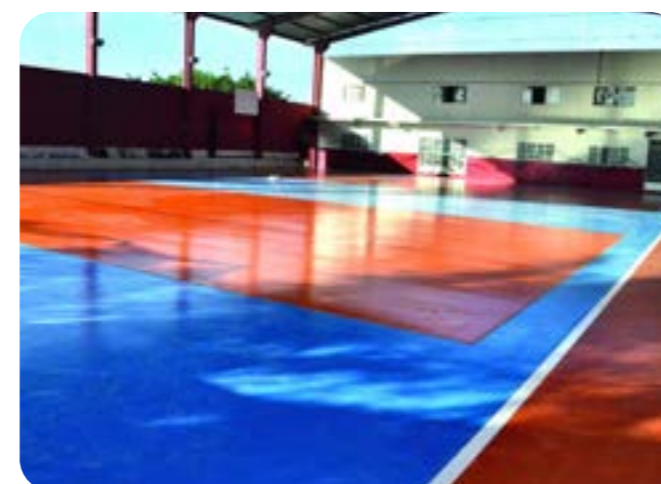
Reformas das Quadras poliesportivas com apoio da APAM
