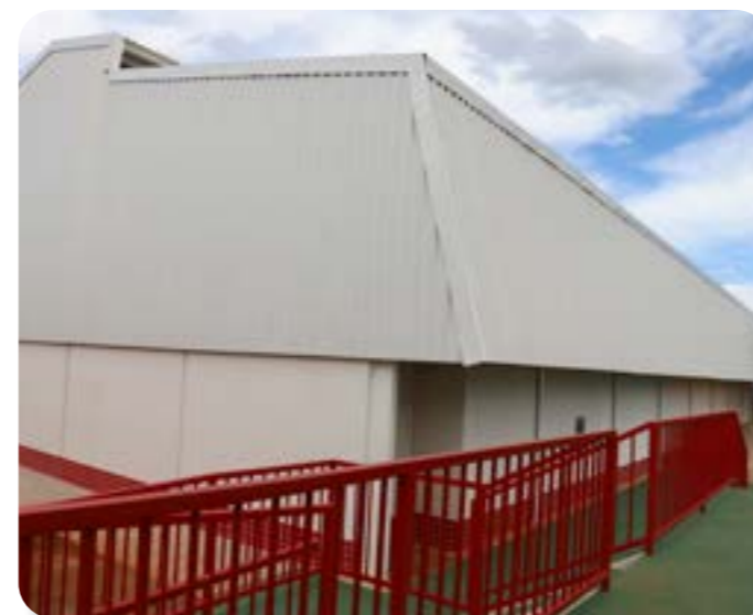
Calçadas adaptadas para cadeirantes e área externa do Espaço Multiuso
